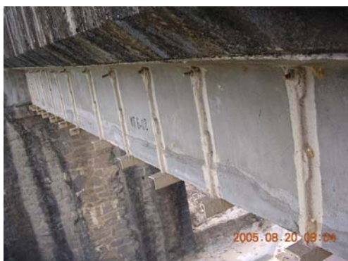
Hình 3. Hiện trạng cầu đường sắt Km 411+800 thời điểm 8/2005
