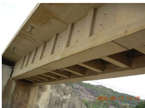
Hình 4. Hiện trạng cầu đường sắt Km 983+900 thời điểm 8/2005
