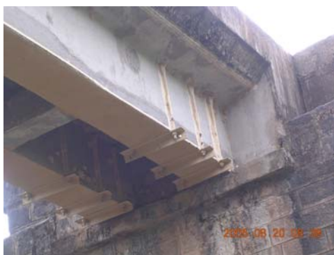
Hình 2. Hiện trạng cầu đường sắt Km 410+580 thời điểm 8/2005
