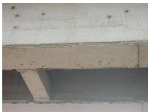
Hình 5. Hiện trạng cầu đường sắt Km 995+693 thời điểm 8/2005
